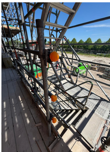
Figuur 9: beschermingsdoppen uitstekende delen
