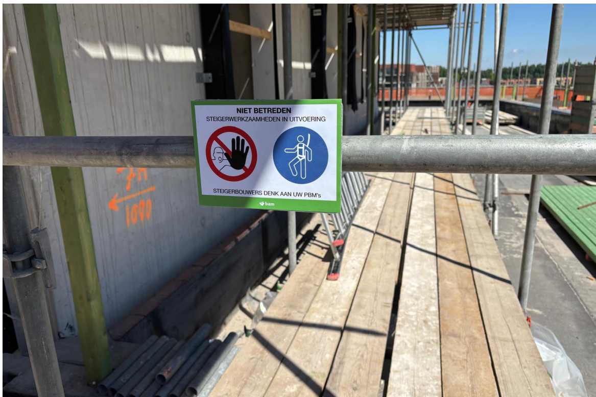
Figuur 70: afbeelding afzetten steiger i.v.m. werkzaamheden
