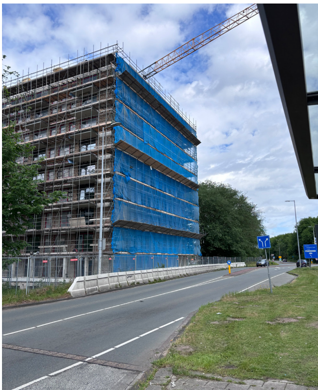
Figuur 65: vangvoorziening over meerdere verdiepingen Voorbeeld betreft geen BAM werk
