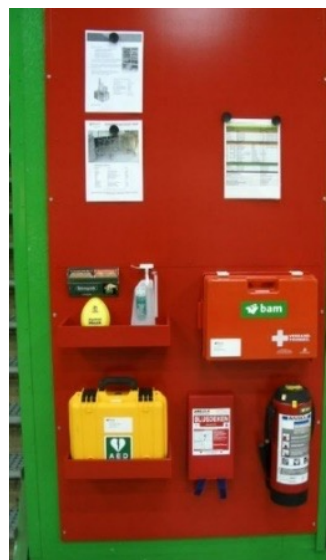
BHV plaats verdieping
